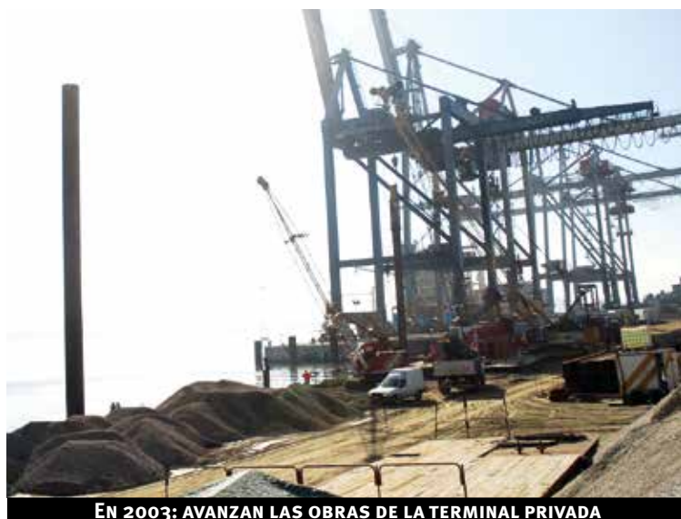
EN 2003: AVANZAN LAS OBRAS DE LA TERMINAL PRIVADA
